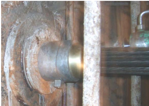
08-7844 安装（预紧）照片
