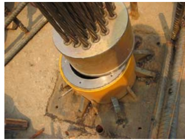
(b) 底部固定后工作锚失稳
