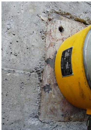
工作垫板凹陷变形
