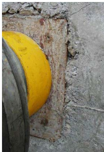
工作垫板凹陷变形及锚固墩产生裂缝
