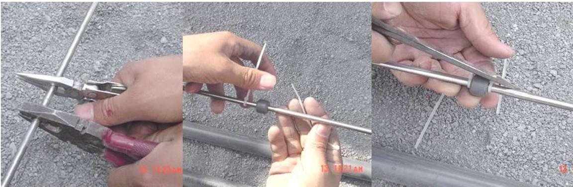
4.9 扎带必须拉紧，以在套保护管时支撑环不会在测杆上滑动为准，支撑环的间距以隔 1.5 米左右为宜。
