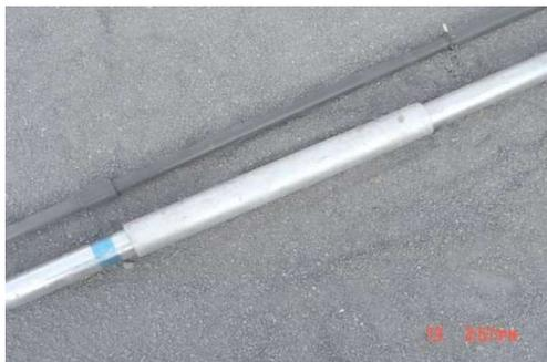
5) 施工期土石坝回填变形较大, 所有保护管推荐伸缩连接而不必使用管箍丝扣方式连接。
