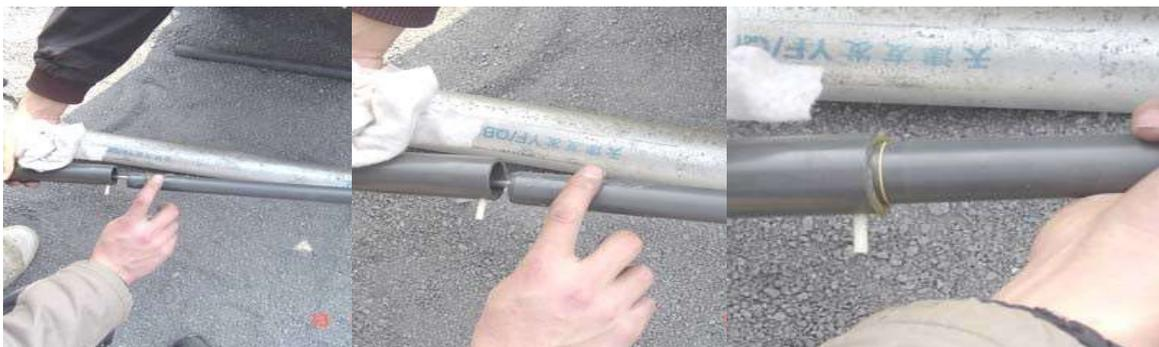
4.7 将伸缩套管两端的 4 支尼龙螺钉旋入用工具拧紧，避免保护管在连接的过程中相对伸缩套管产生移位。
