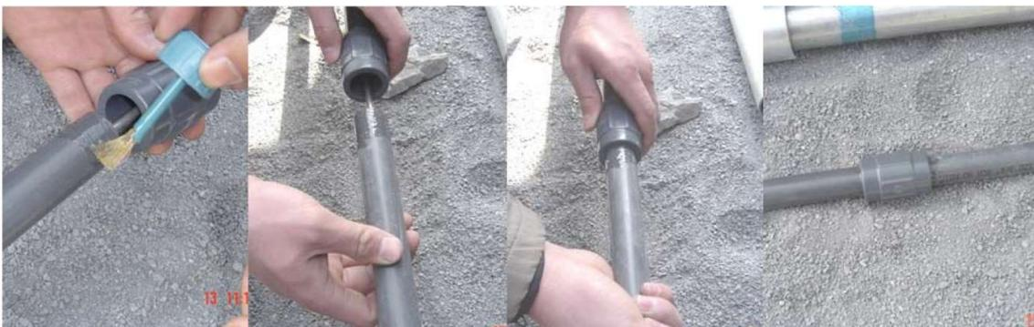
4.11 重复上述 4.4~4.10 步，继续连接测杆及 PVC 保护管。
