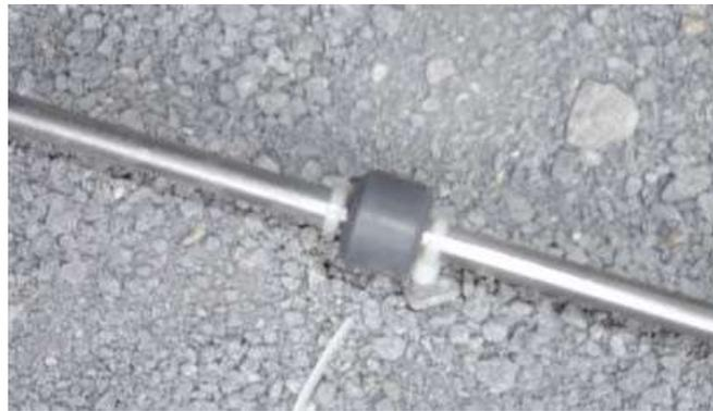
4.10 在固定好支撑环后即可连接保护管，连接保护管时，将伸缩管端部涂抹适量的 PVC 胶，然后套入 PVC 管接头，再连接下一段保护管。
