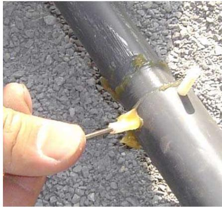
4.8 如果伸缩节外露的传递长度少于 3m，应提前接入下一根传递杆（注意始终避免传递杆相对传感器产生扭转）并装上减摩环，将支撑环两端各扎上尼龙扎带并剪去多余的扎带，便于保护管的套入。
