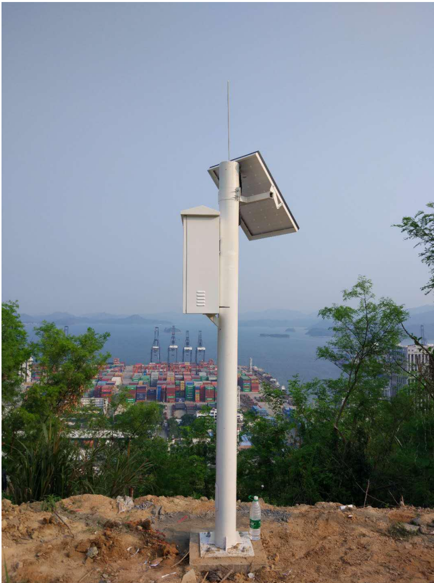
图 6.1 一体化监测站安装在柱体上
